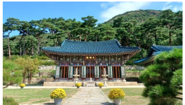
진관사 한문화국제체험관 신축 소방공사 감리용역
