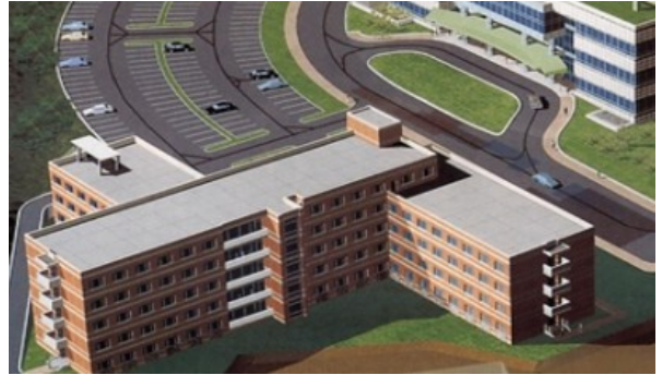
봉포리 연수원 건축기계설비공사 감리 용역
