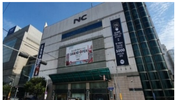
구로 NC 백화점 철골주차장 신축 소방공사 감리용역
