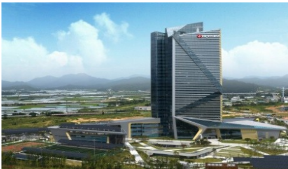
한국전력 성동지사 변전소 및 전력구 소방시설 점검용역
