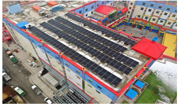
춘천연료전지발전소 신축 전기설비공사
