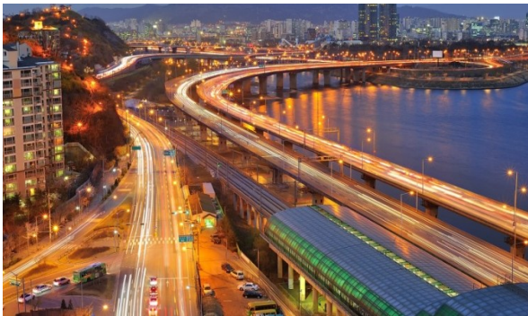
성동도로사업소 교통신호기 신설 및 개량공사
